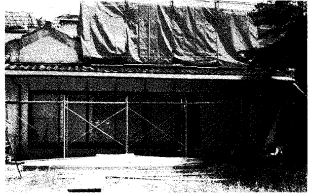
(写真1) プレイルームへの改修工事
