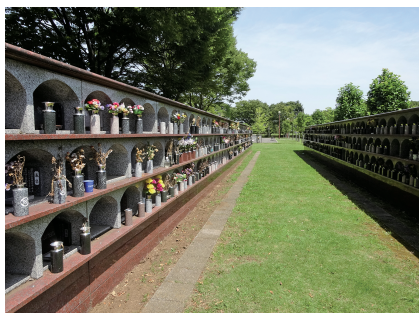
写真4 立体型屋外墓地
