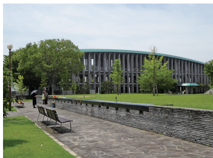
写真3 3階建て屋内墓地全景
